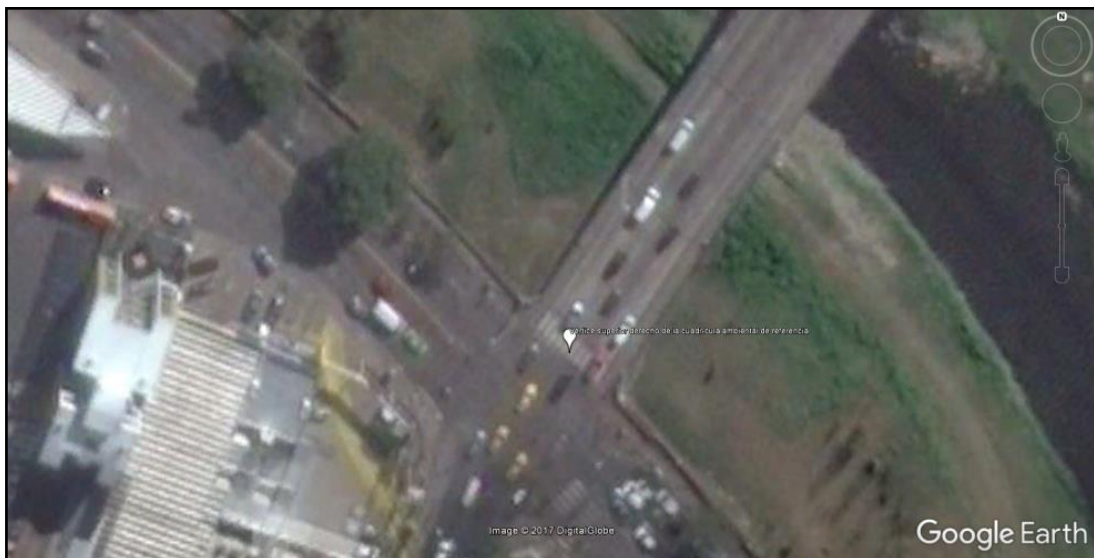
Figura 8: Puente Alvear, Ciudad de Córdoba.
