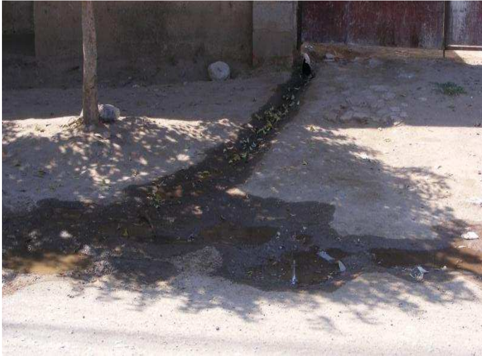
Foto 5. Eliminación de agua domiciliaria por entubado.
